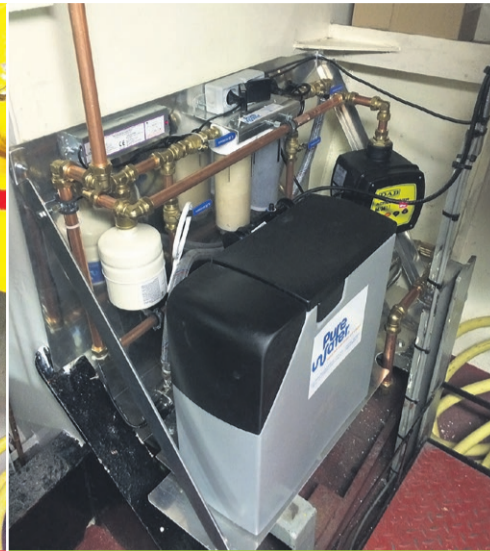
Situatie na: de opslagtank is verdwenen en vervangen door de WKU van Pure Water.
