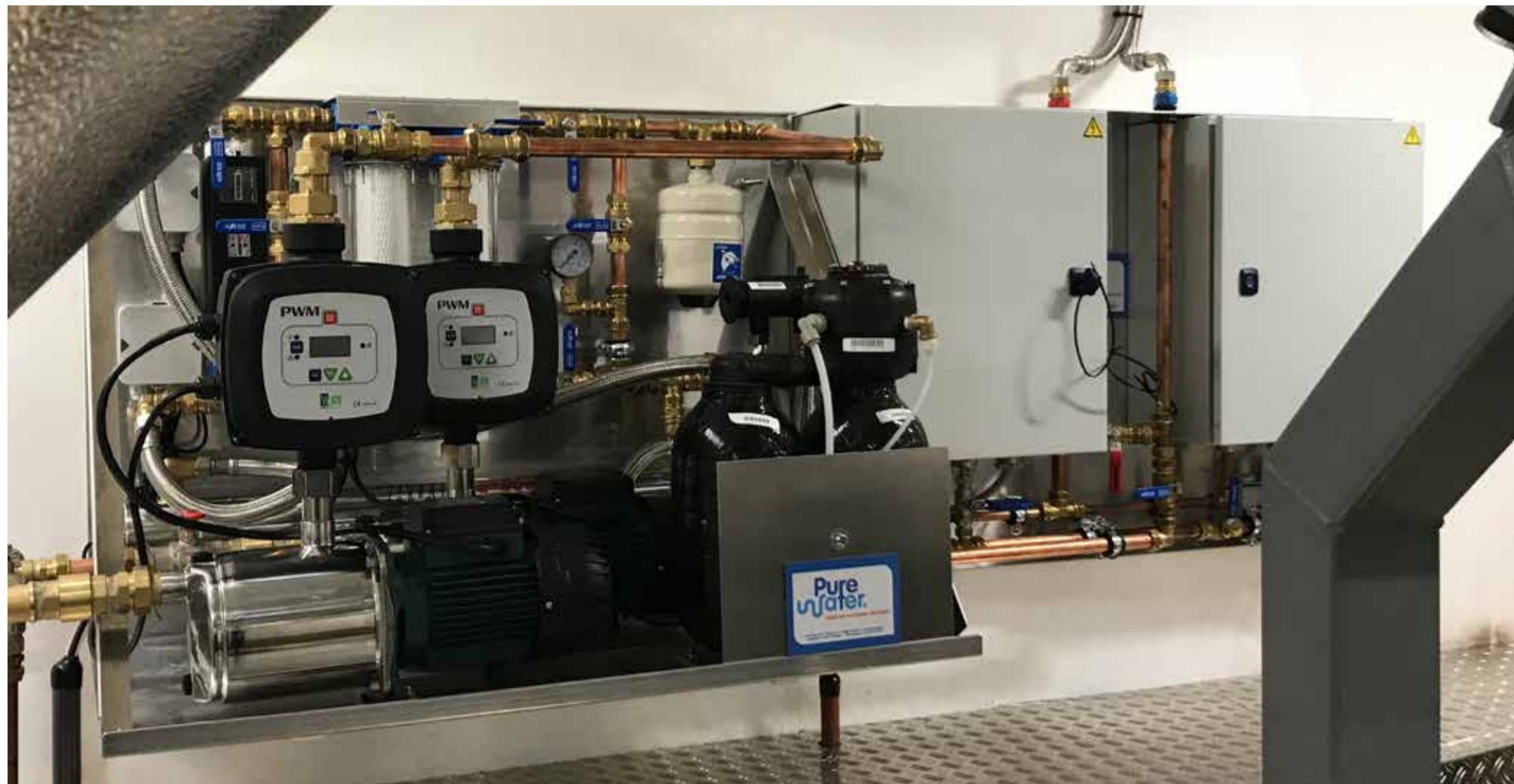
Water Kwaliteit Unit plus doorstroomboilers, standaard met klasse isolatie.
