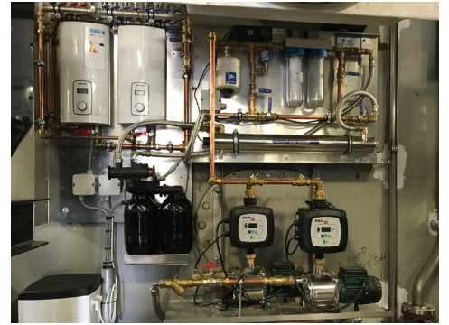
Inkijkje in de machinekamer in aanbouw op MS Camaro VII.
